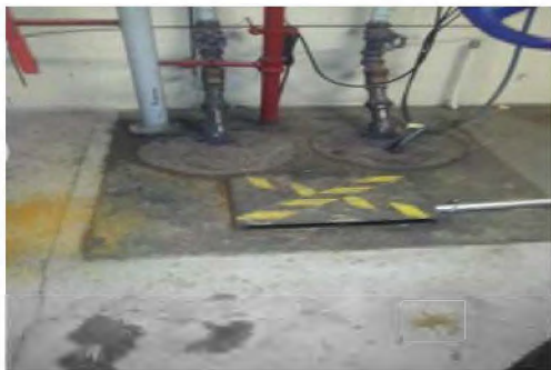
D2043 - Rain Water Sump Pumps - Replace
